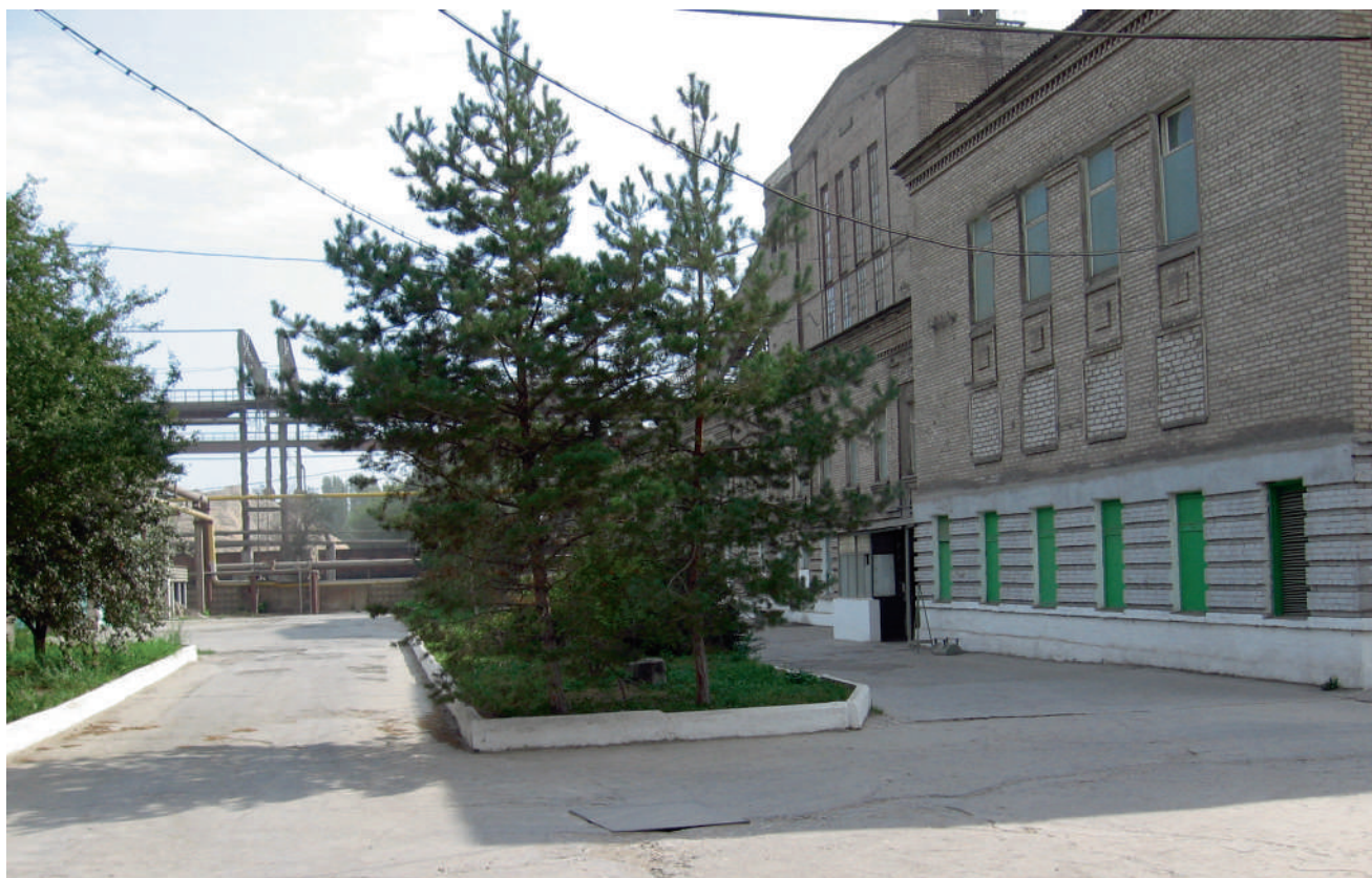
Здание административного корпуса ТЭЦ
